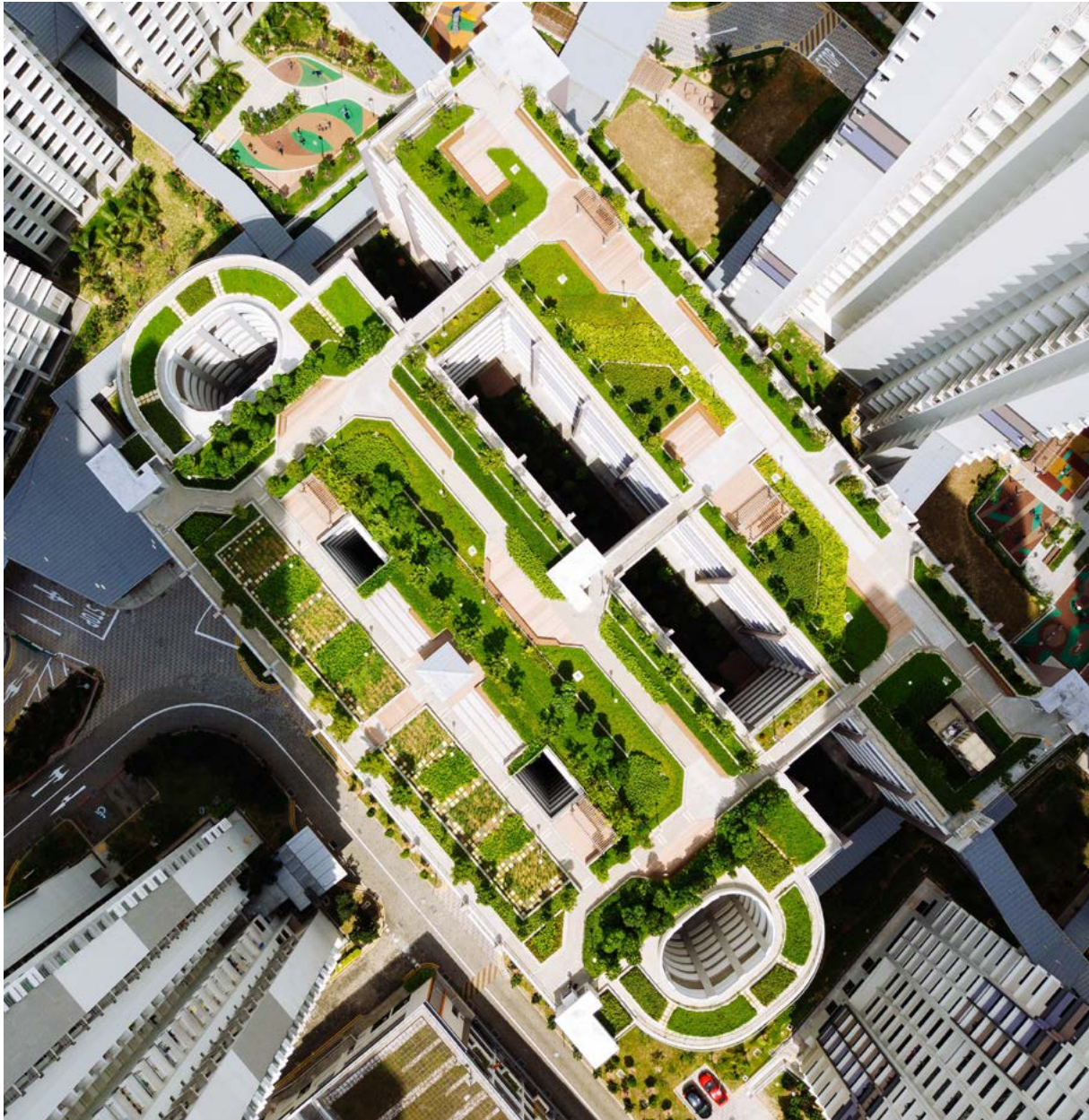
Gründächer können Regenwasser zurückhalten und durch Verdunstung Häuser kühlen (Bild: chuttersnap/Unsplash).
